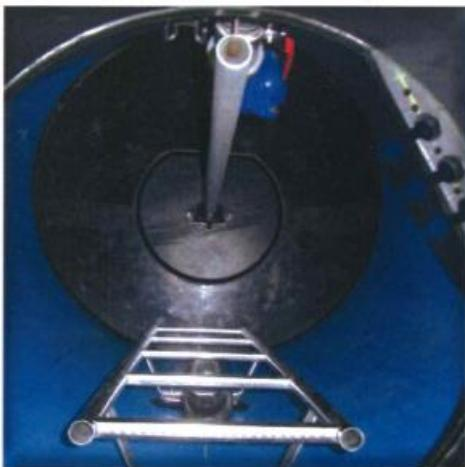
Bild 1 : Pumpenschacht Einzelanlage
